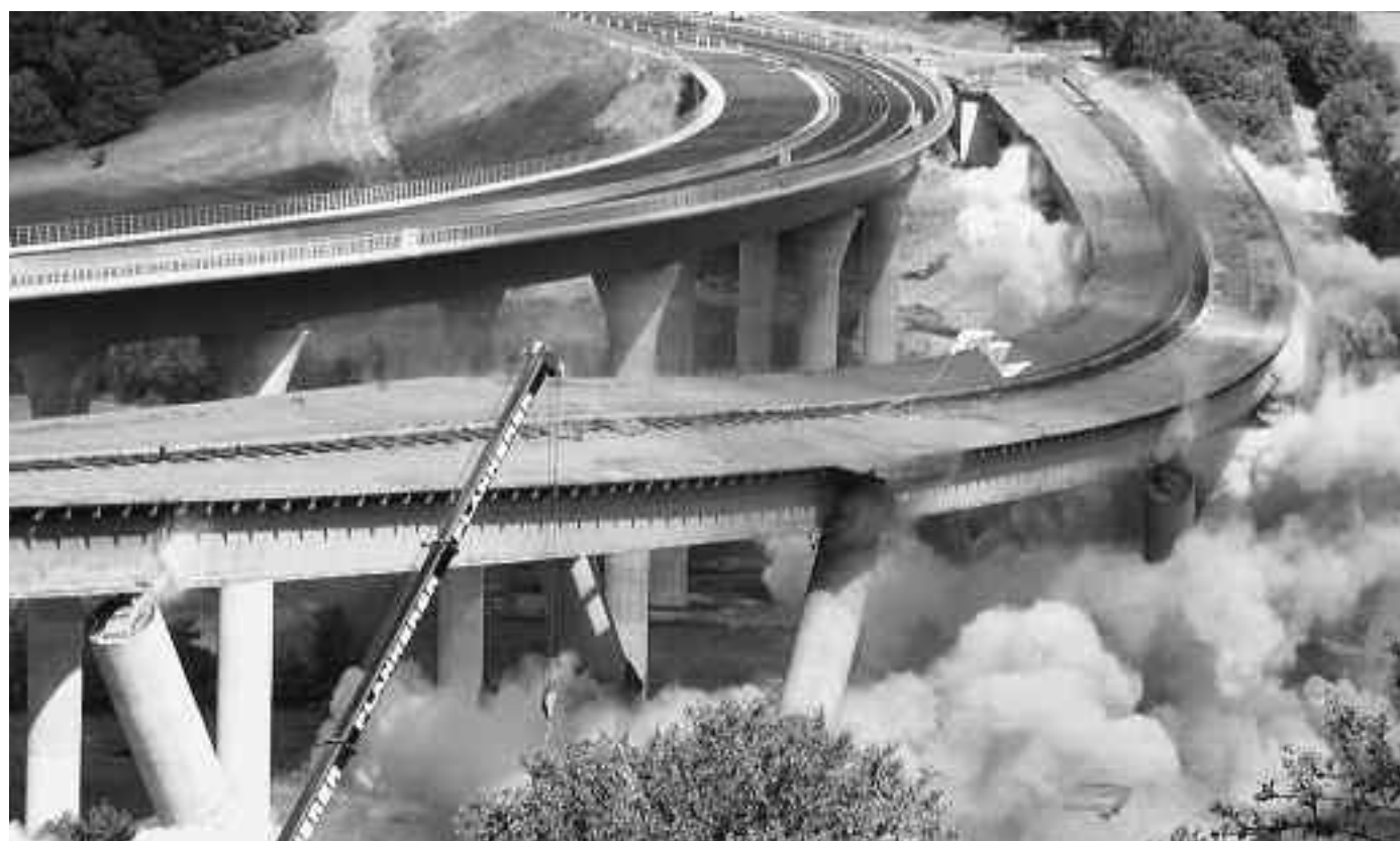
Spektakuläre Sprengung der alten Sinntalbrücke.
