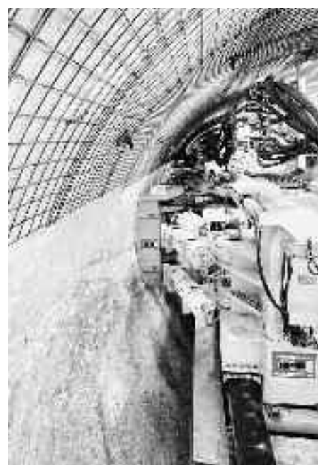
Für den sicheren Vortrieb entwickelten die Ingenieure von Herrenknecht in Kooperation mit dem bauausführenden Unternehmen, der Schweizer Marti Tunnelbau AG, eine doppelte Rückfallsicherung mit einer vollen Redundanz der verfügbaren Verspann-Ebenen für die 130 m lange und 800 t schwere TBM. Foto: Herrenknecht
