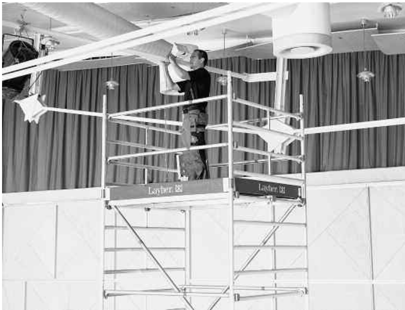
Sicheres Arbeiten in der Höhe – Layher-Fahrgerüste im Einsatz.
