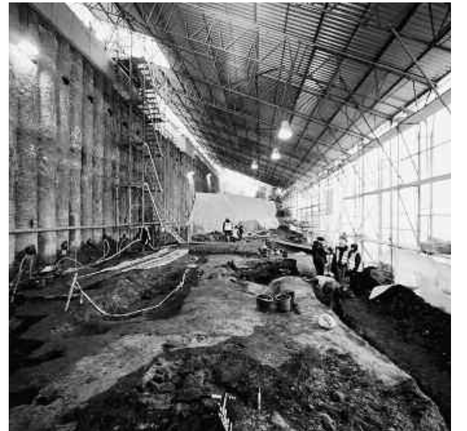
Eine Interims-Überdachung durch Rux-Alu-Rasant Wetterschutz-Kassetten schützte erfolgreich die Ausgrabungsstätte auf dem Gelände des neuen Europäischen Hansemuseums. Die Archäologischen Befunde werden in das Museumskonzept integriert. Foto: Scaform-rux Deutschland
