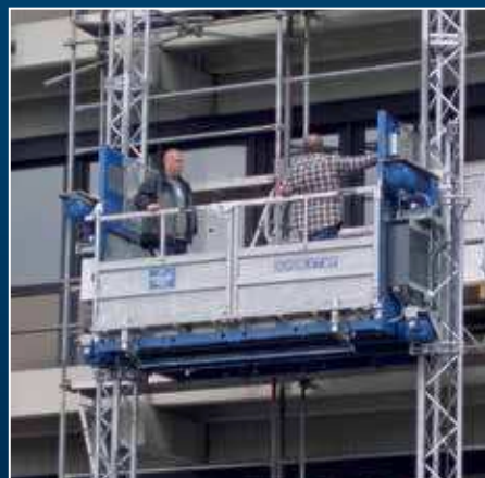
MX 2024 – B30 parallel zur Fassade
