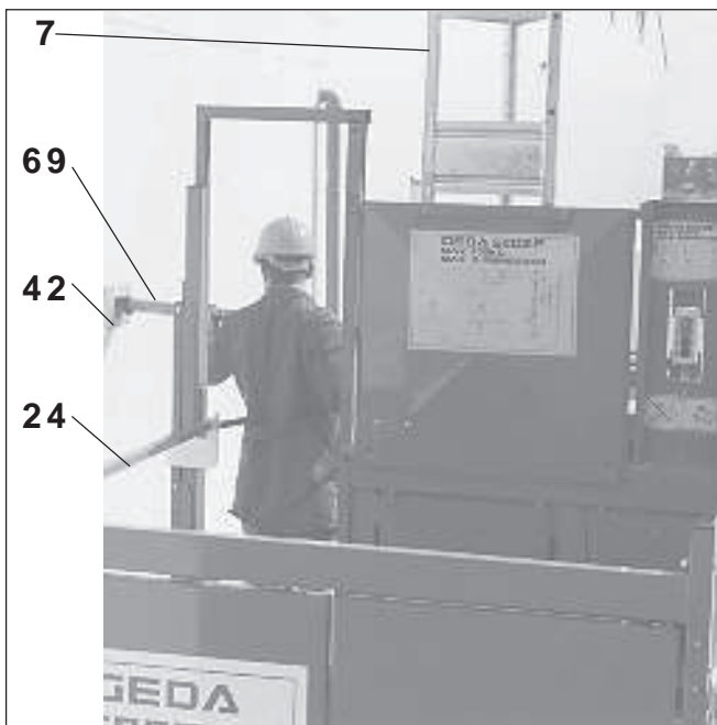
Fig. 39 Bühne mit Zugang zum Montagegesteg
