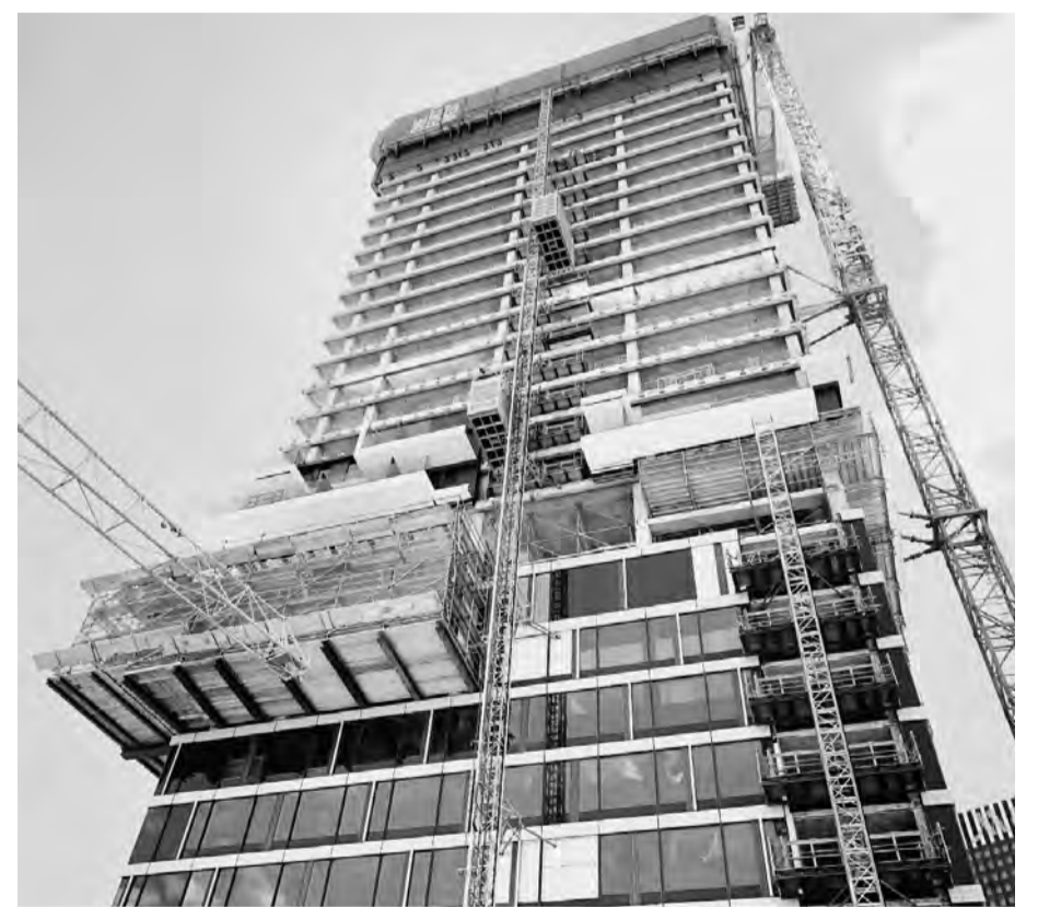
Auskragende Gerüste sind für die Montagearbeiten erforderlich. FOTO: TEUPE
