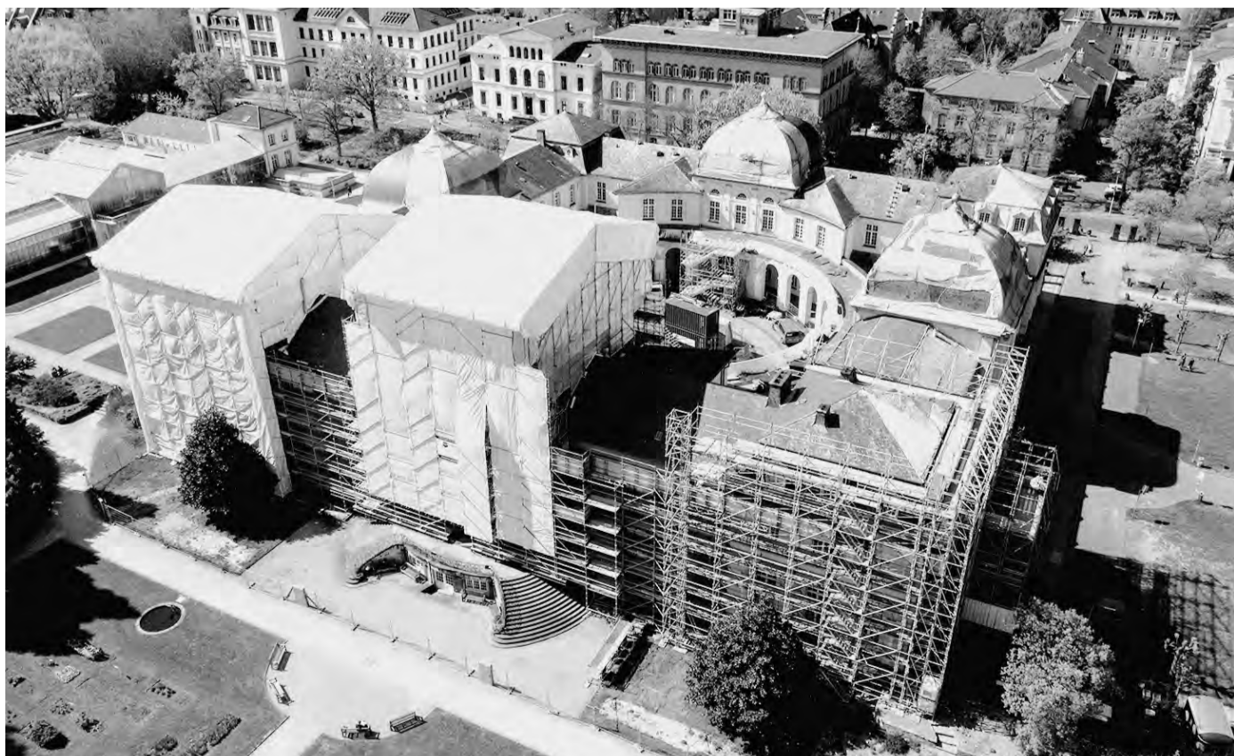
Seit 2017 wird die Schieferdeckung des Poppelsdorfer Schlosses in Bonn einschließlich der Schalung und Dachentwässerung erneuert. Außerdem werden an den Fassaden Putz- und Anstricharbeiten ausgeführt und die Fenster saniert. FOTO: TEUPE & SÖHNE GERÜSTBAU
