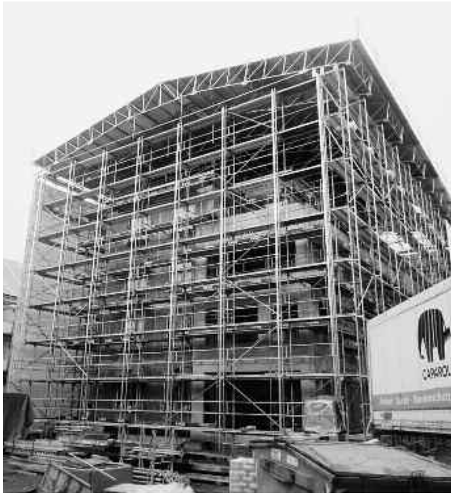
Über einem bestehenden Fassadengerüst wurde ein Kassettendach errichtet. Foto: TS Gerüstbau
