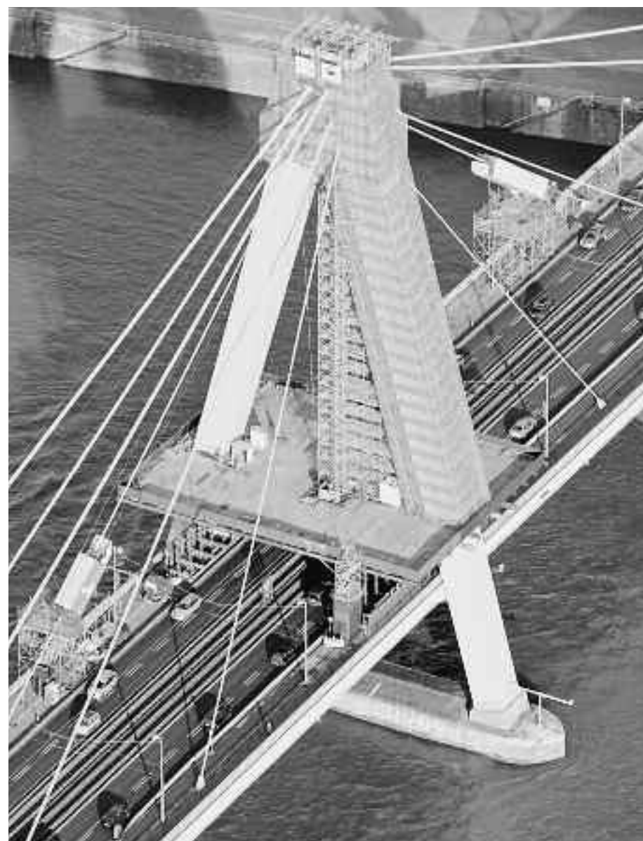
Für die auszuführenden Korrosionsschutzarbeiten hat Teupe den knapp 80 m hohen Pylon vollständig eingerüstet und mit einer staubdichten Einhausung versehen. Foto: Teupe/Bernhard Fischer
