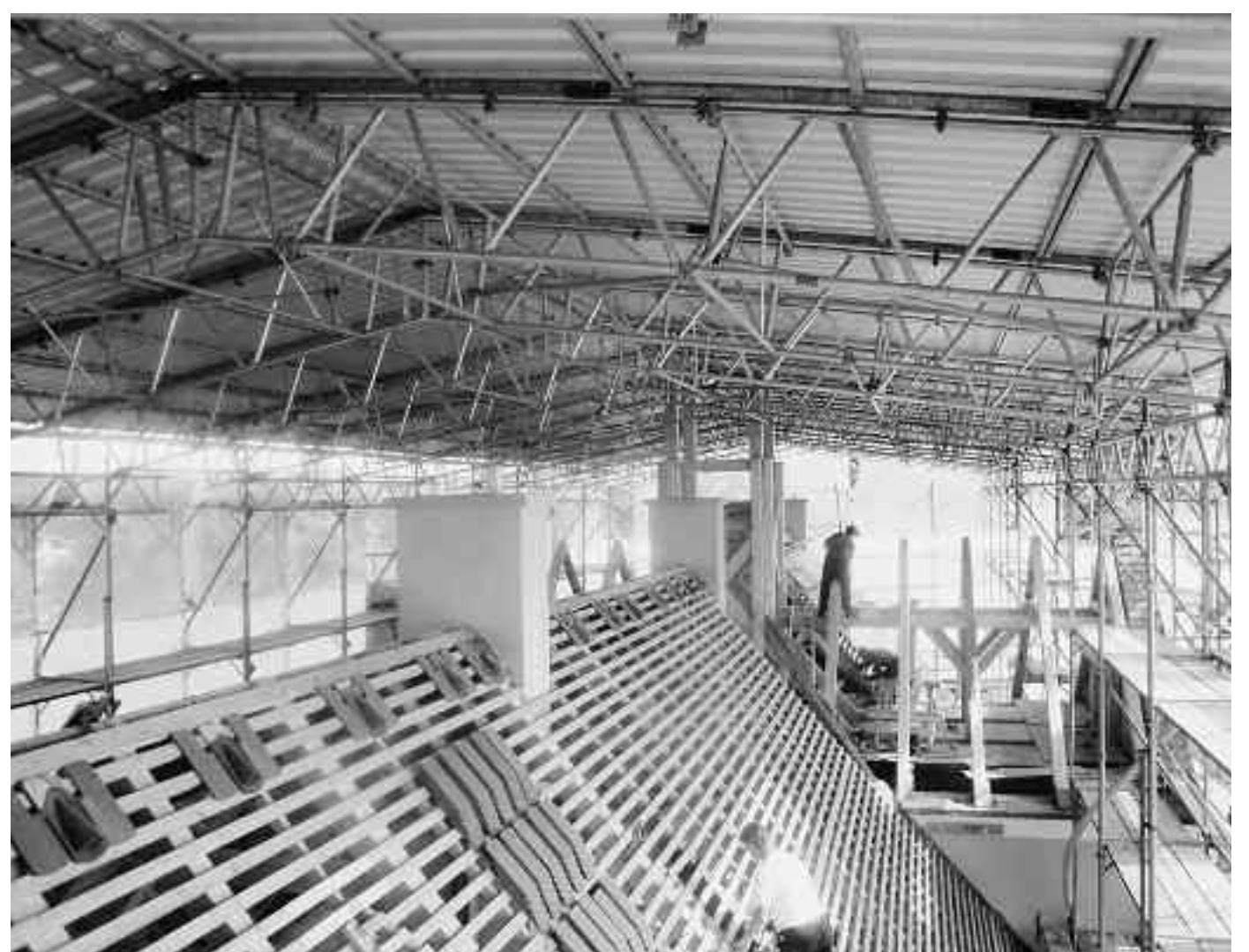
Beim Aufbau des Wetterschutzdaches am Jagdschloss Grillenburg kam das plettac Moduldach 75 zum Einsatz.
