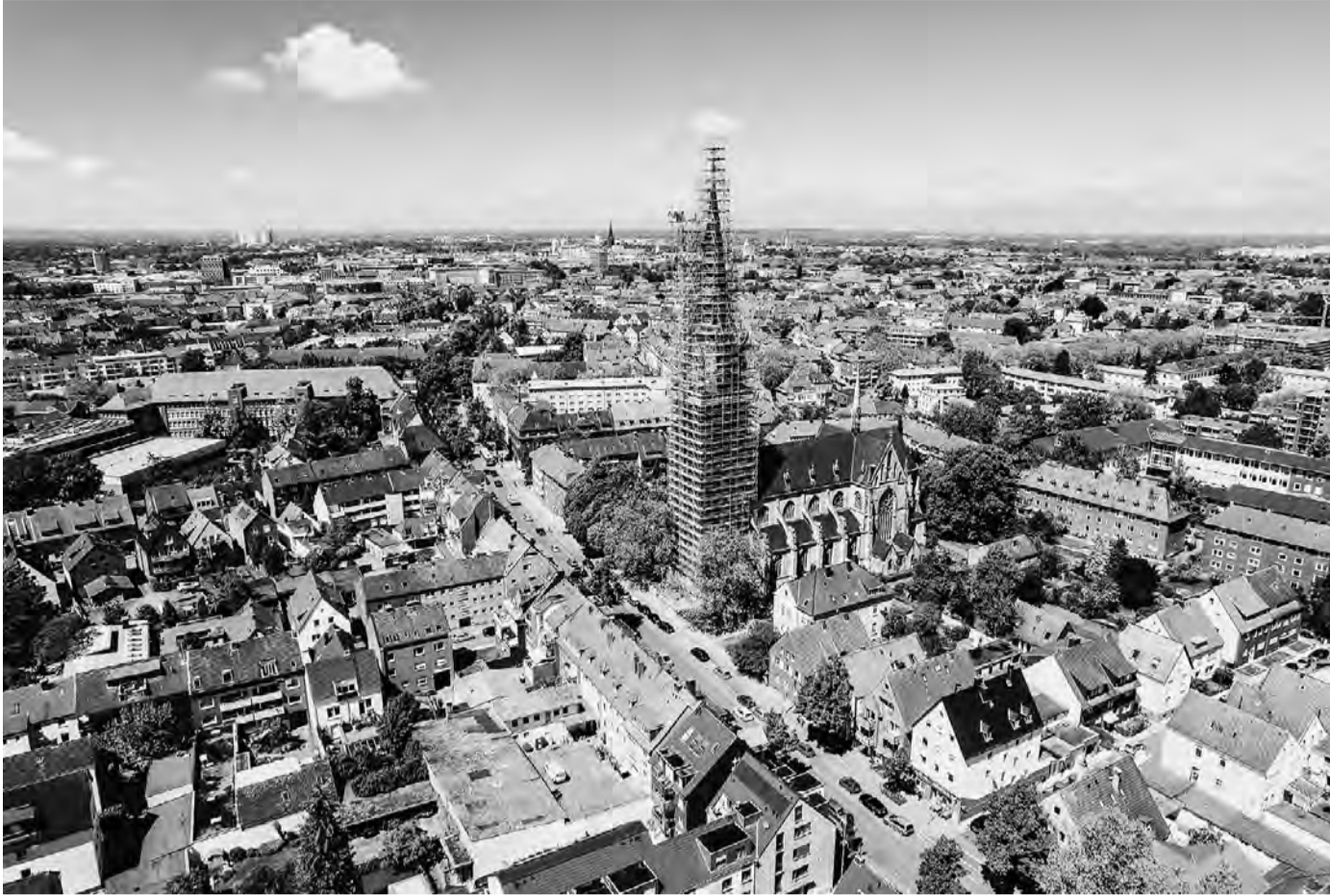
Aufgrund der beengten Baustelleneinrichtung musste das benötigte Material „just in time“ angeliefert und verarbeitet werden. FOTO: TEUPE
