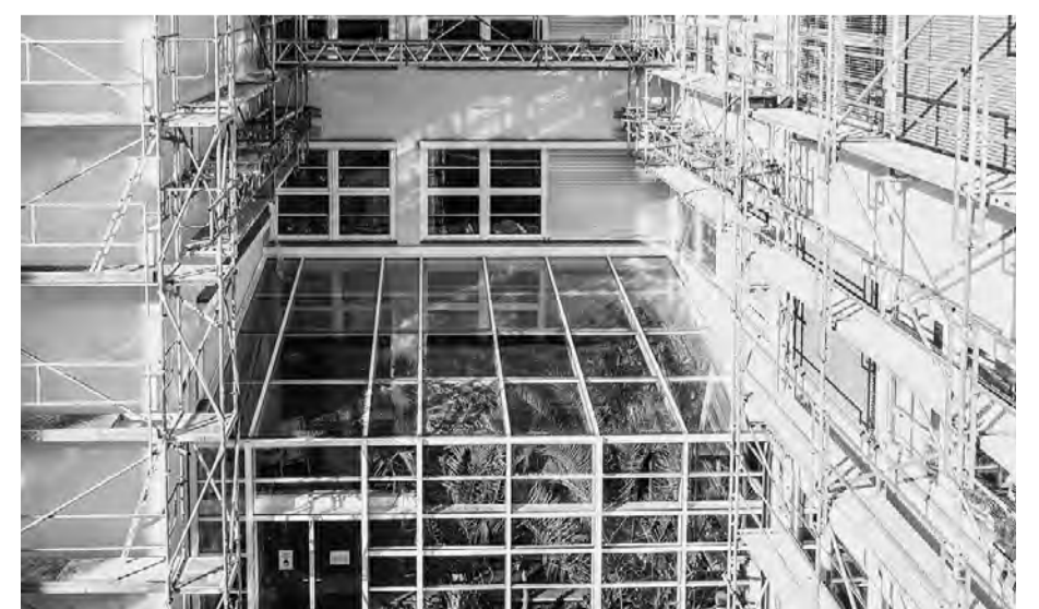
Das TRBS-Geländer als Außengeländer an der Landesdirektion Chemnitz. FOTO: ALFIX
