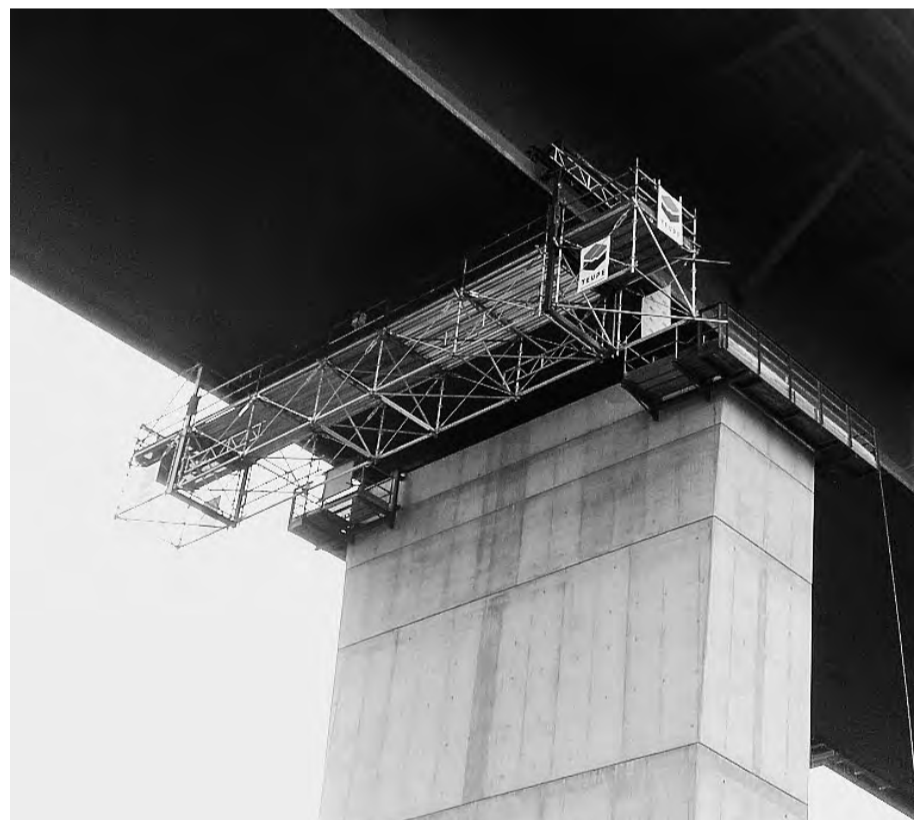
Das Gerüst hat eine Breite von 2,5 m und eine Spannweite von insgesamt 16 m. Die Konstruktion wurde als verfahrbares, elektrisch angetriebenes Hängegerüst aus freitragenden Fachwerkträgern realisiert
